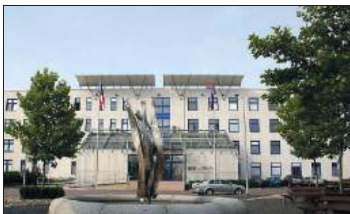
SÍDLO KRAJSKÉHO ÚŘADU KARLOVARSKÉHO KRAJE
